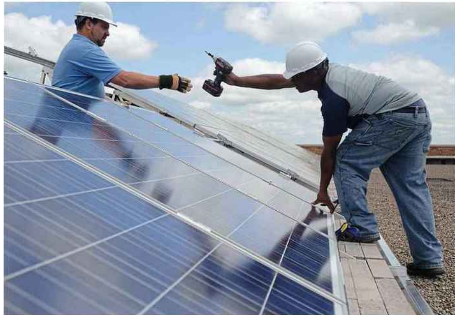
Les couvreurs spécialisés dans la pose de panneaux photovoltaïques n'ont pas de mal à trouver un job.
